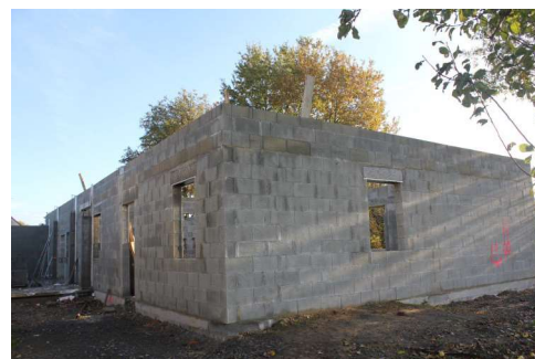
Site du Theil en construction
